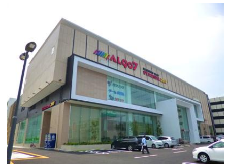
▲アルゴセブン 外観
